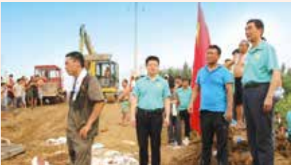
参与邢台灾区封堵溃堤决口
