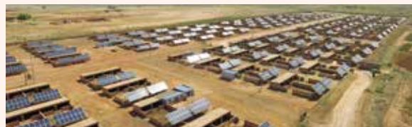
宁夏盐池光伏扶贫电站
